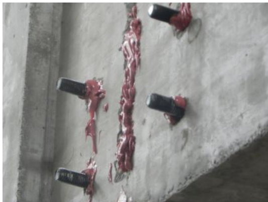
② 灌注结构胶，对穿螺栓
