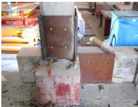
⑤ 焊接钢板成全包钢套
