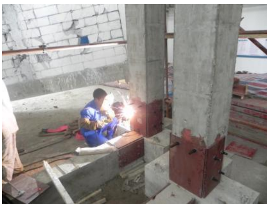
④ 焊接钢板成U型钢套
