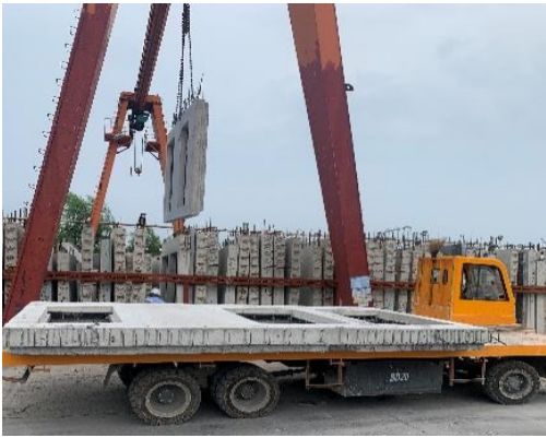
图 3.3.10 平板车倒运构件
