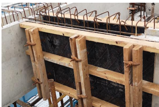
图 6.4.17 预制主次梁节点封模
