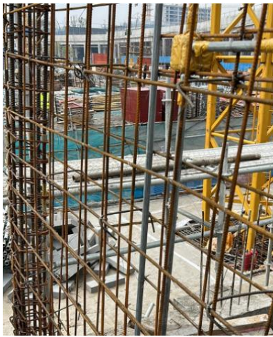
图 6.1.7 墙柱钢筋绑扎效果（一字型）
