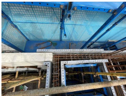
图 6.6.23 现浇段钢筋绑扎及模板支设
