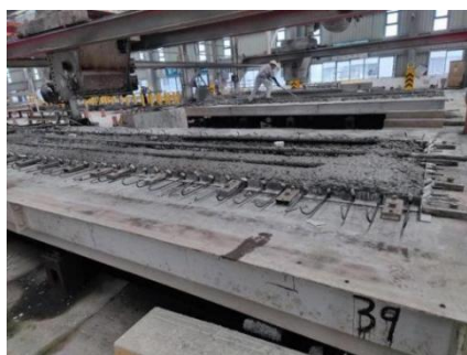
图 3.2.7 混凝土浇筑
