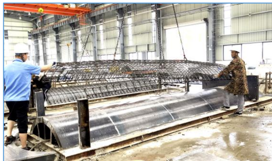
图 6.5.27 弧形板钢筋整体吊放
