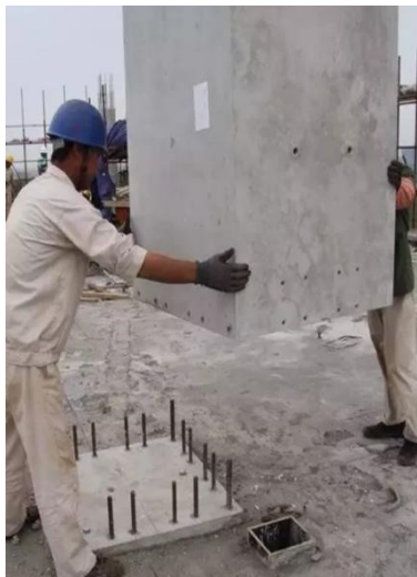
图 6.4.10 预制柱落位
