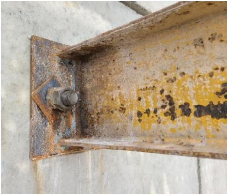
图 5.3.2 悬挑钢梁作用于构件表面
