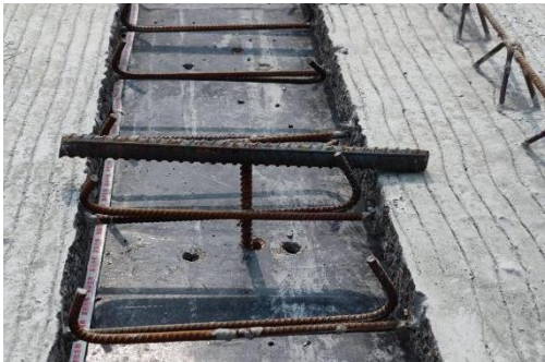
图 4.3.12 后浇带胡子筋搭接
