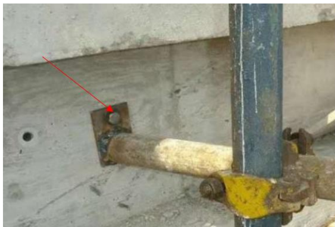
图 5.1.3 PC 外墙预埋锚栓做法
