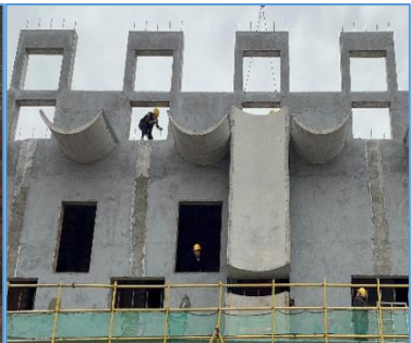
图 6.5.36 构件吊装
