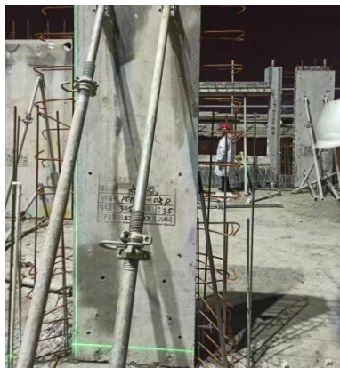
图 4.4.5 预制墙体校正
