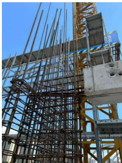
图 6.2.15 预制外墙带连梁处箍筋情况
