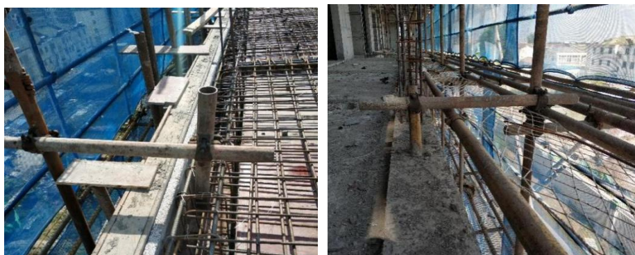
图 5.1.1 预埋连墙件钢管(现浇结构)
