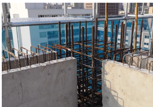
图 6.4.16 预制梁柱节点钢筋绑扎
