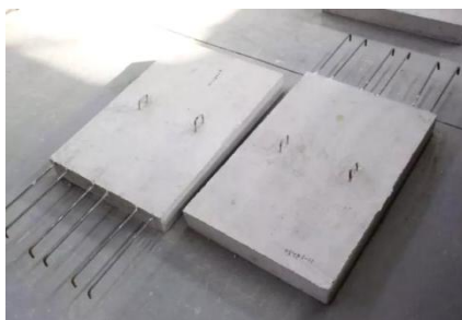
图 2.10.1 预制空调板构造
