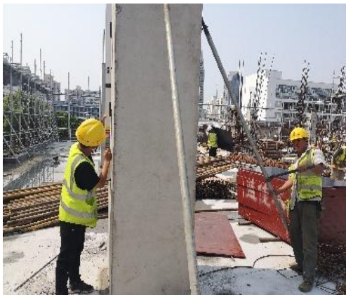
图 6.4.11 安装并调节斜支撑
