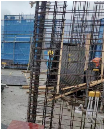
图 6.1.6 墙柱钢筋绑扎效果（L 型）
