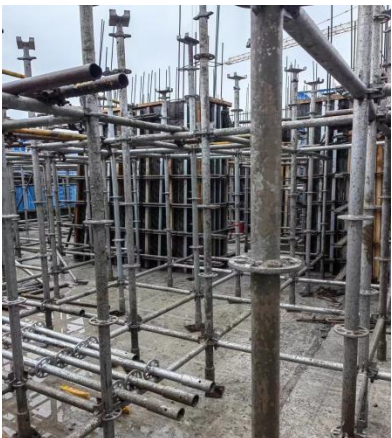
图 6.1.4 盘扣支撑架及木模
