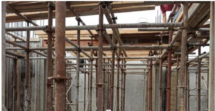
图 4.3.1 轮扣式满堂支撑架
