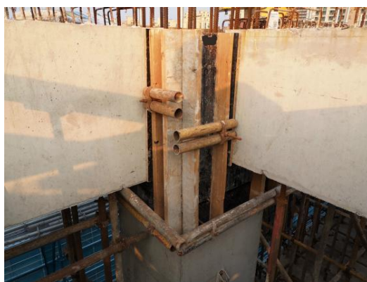
图 4.6.13 预制梁柱节点现场支模图
