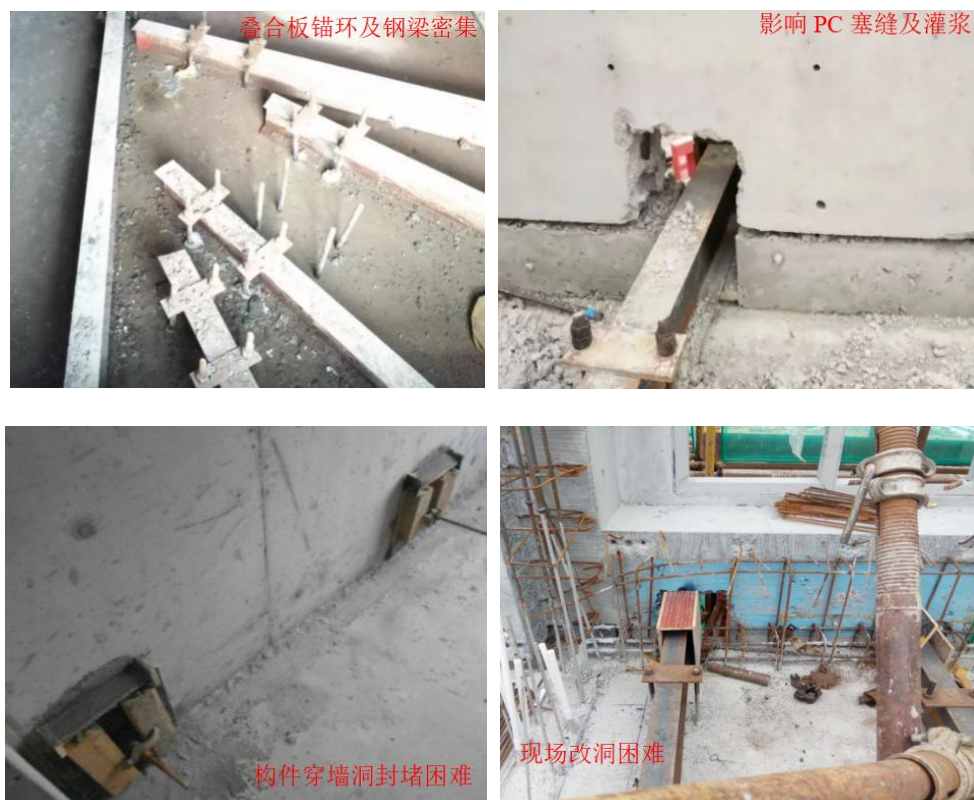
图 5.2.2 穿墙悬挑工字钢存在的弊端
