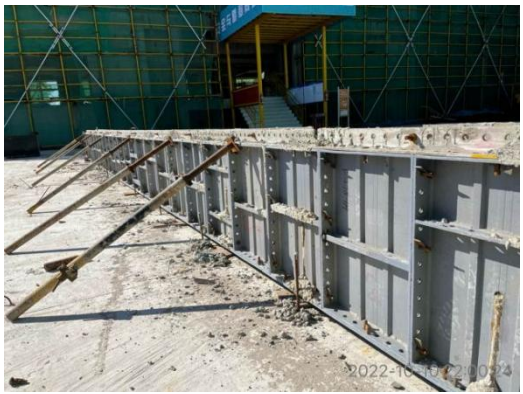
图 6.6.14 支设侧模及浇筑混凝土
