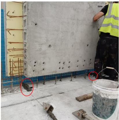
图 6.3.9 预制墙底部短边先坐浆
