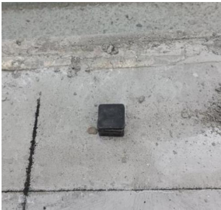
图 6.3.8 预制墙底部标高垫片
