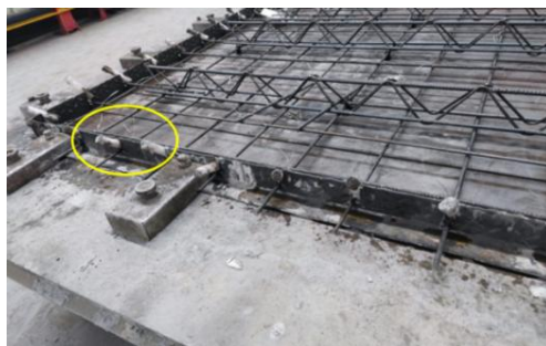
图 3.2.6 侧模孔封堵
