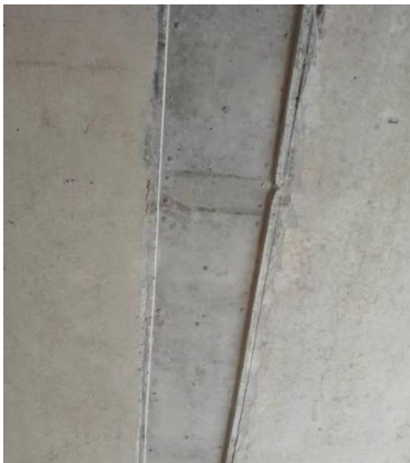
图 4.3.18 铝模企口优化拆模效果
