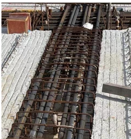
图 4.6.11 现场封闭箍筋绑扎图
