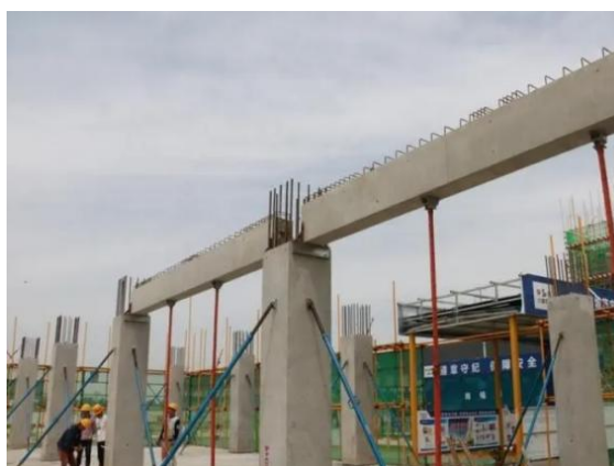
图 4.6.5 叠合梁吊装完成
