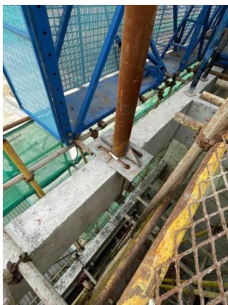
图 6.6.19 独立钢支撑安装固定
