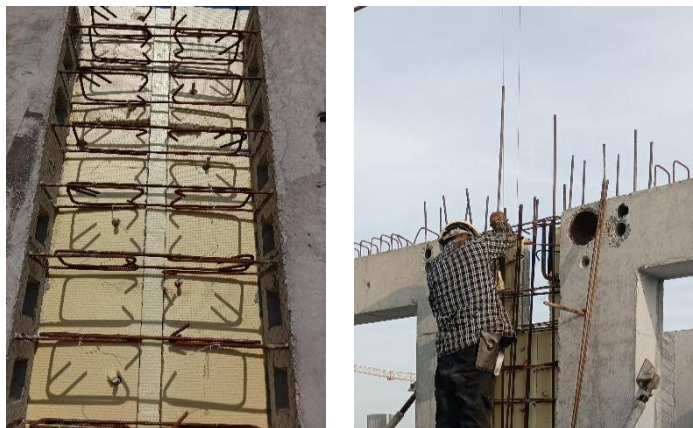
图 4.4.7 一字型节点钢筋绑扎
