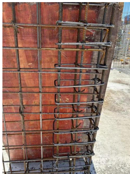
图 6.2.8 一字型节点绑扎效果
