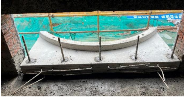
图 6.5.38 螺杆孔水泥砂浆封堵
