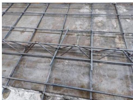
图 3.2.4 平行于桁架筋的底筋放置
