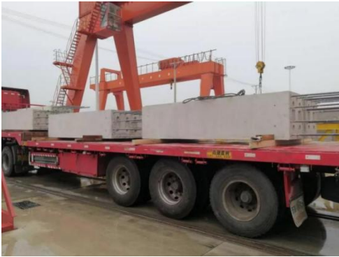
图 3.4.4 预制柱构件运输
