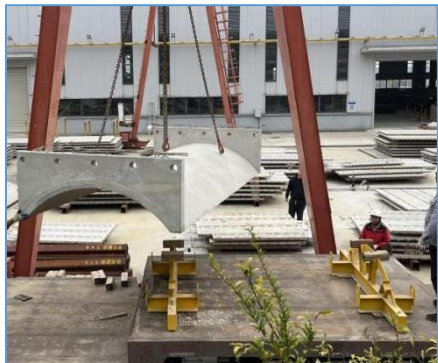
图 6.5.33 弧形板水平吊运
