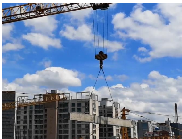
图 6.4.15 预制梁吊装
