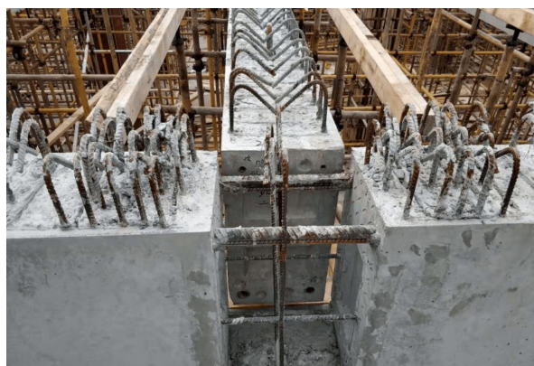
图 4.6.9 主次梁端节点施工
