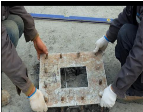
图 4.5.1 预留柱筋复核调整
