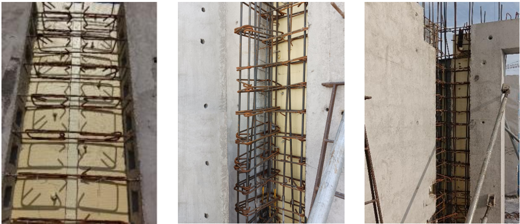
图 6.3.15 一字型节点钢筋绑扎 图 6.3.16 L 型节点钢筋绑扎 图 6.3.17 T 型节点钢筋绑扎
