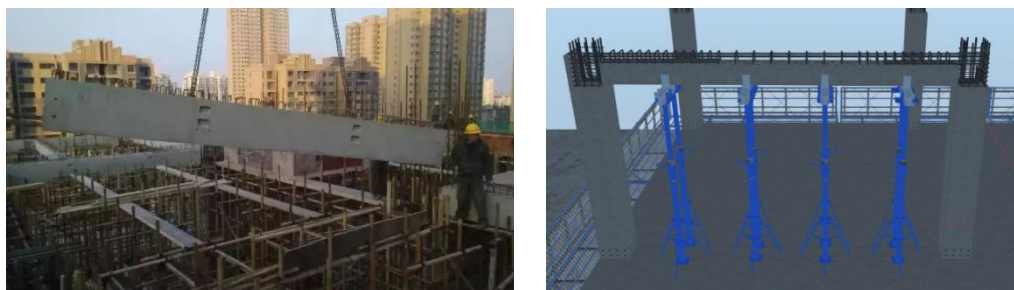
图 4.6.4 叠合梁吊装就位
