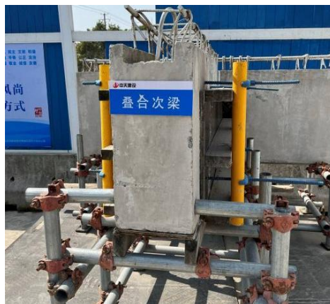
图 4.6.12 预制次梁顶部预留凹槽
