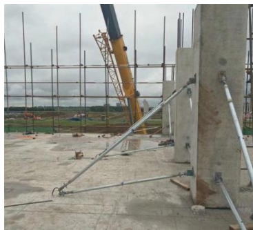
图 4.5.4 预制柱校准、固定斜撑
