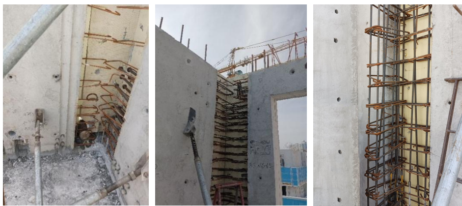
图 4.4.11 L 型节点钢筋绑扎
