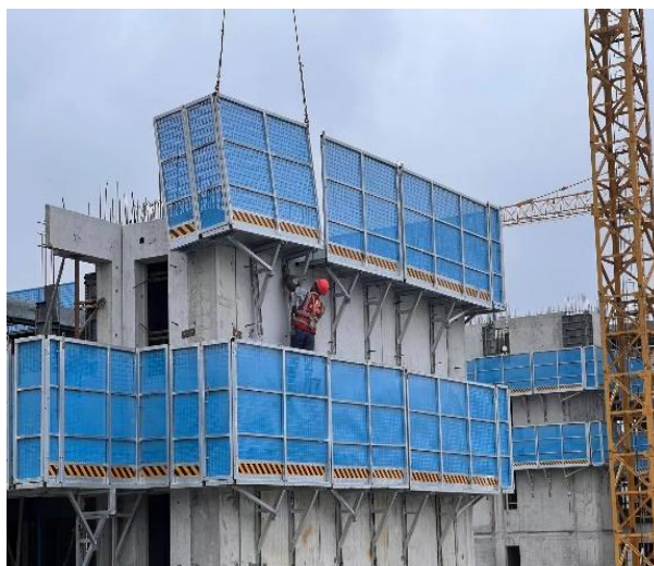
图 5.6.2 夹心保温外墙外挂架构造
