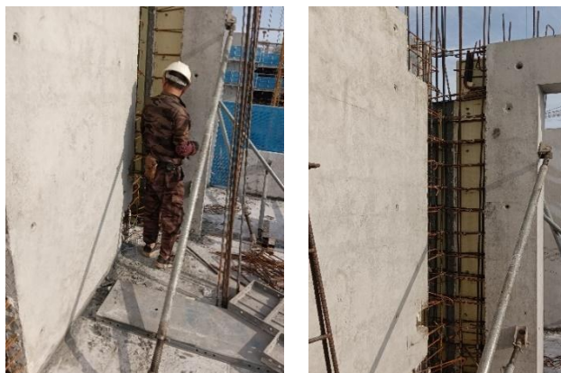
图 4.4.13 T 型节点钢筋绑扎
