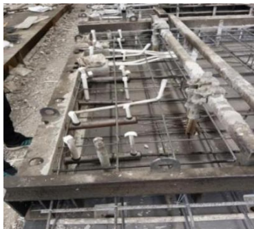
图 3.3.5 灌浆套筒的预埋
