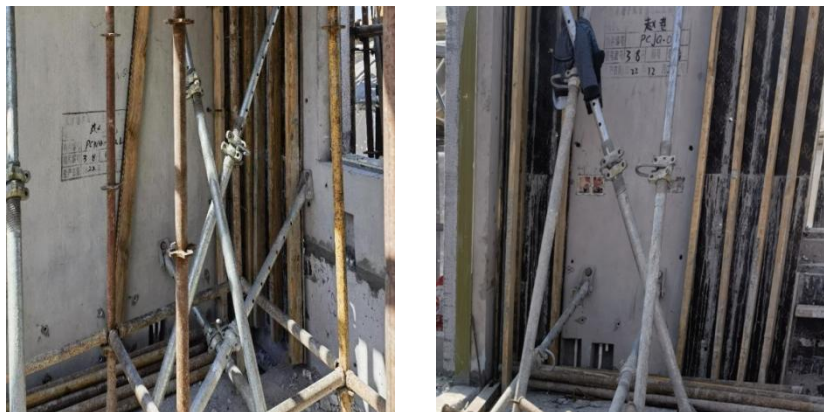
图 4.4.21 剪力墙节点模板支设
