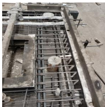
图 3.3.4 PE 棒塞孔处理
