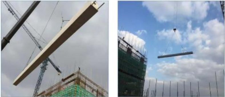
图 4.6.3 叠合梁吊装
