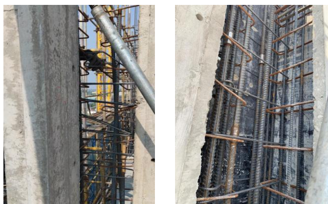
图 4.4.12 L 型节点绑扎效果
