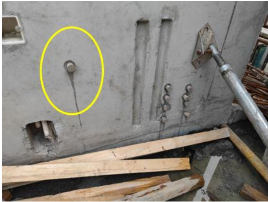
图 4.4.25 套筒灌浆附加高位出浆孔
