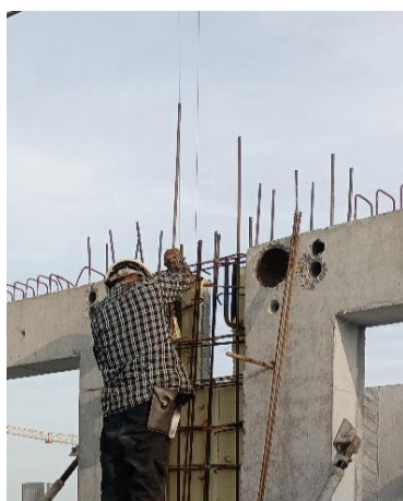
图 4.4.17 一字型节点顶部箍筋安装困难
