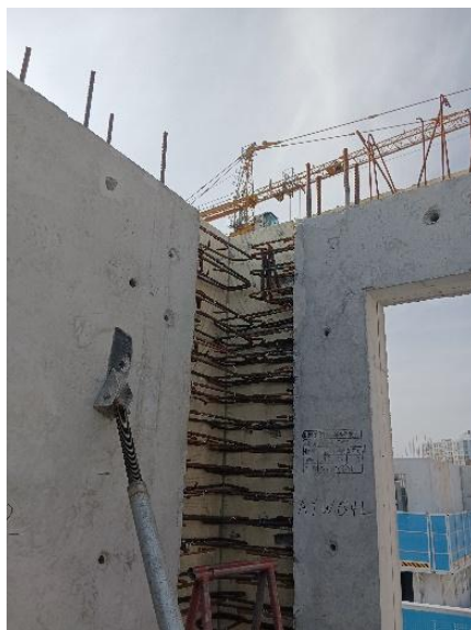
图 6.3.18 GBZ8 钢筋绑扎（L 型节点）
