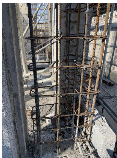
图 4.4.10 L 型节点绑扎效果
