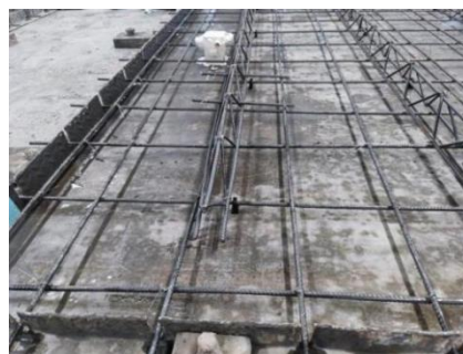
图 3.2.5 桁架筋放置、垂线向底筋插入
