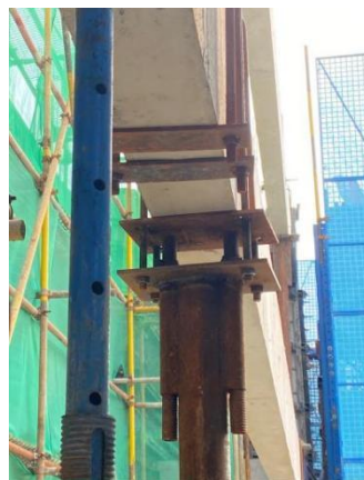
图 6.6.20 独立钢支撑顶托
