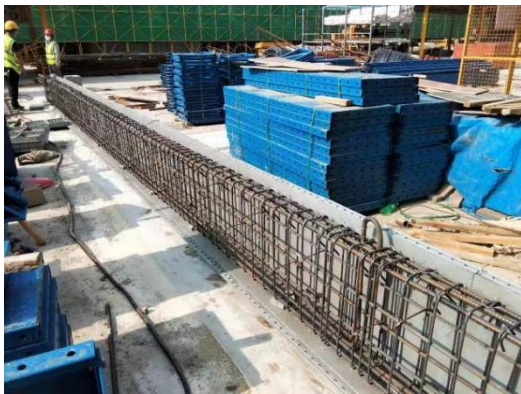
图 6.6.13 铺设底模及绑扎钢筋
