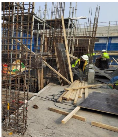
图 6.1.8 墙柱模板安装
