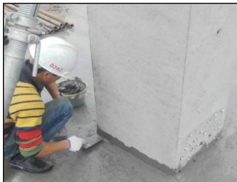
图 4.5.5 柱底砂浆封边
