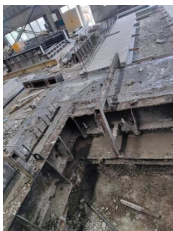
图 3.6.1 侧墙吊模做法示意
