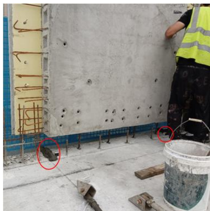
图 4.4.1 预制墙底部短边先坐浆
