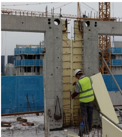
图 6.3.14 保温板条塞缝
