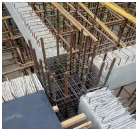
图 4.6.7 梁柱（墙）中节点施工
