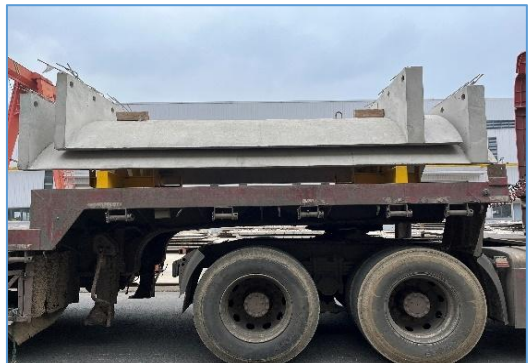
图 6.5.34 预制弧形板水平叠放运输
