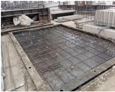
图 3.3.1 外叶板钢筋绑扎
