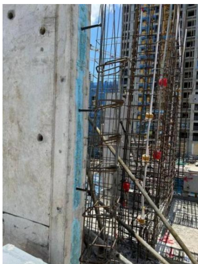
图 6.2.14 连接螺栓与箍筋局部碰撞，上下微调
