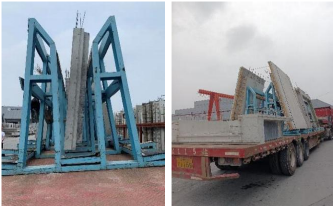
图 3.3.11 预制墙体构件运输
