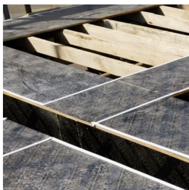
图 4.3.14 粘贴海绵胶条做法
