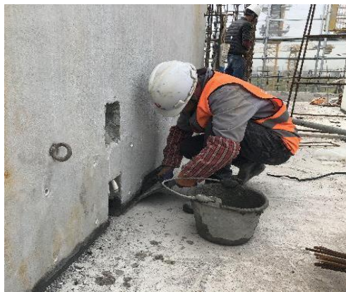
图 4.4.2 预制墙底部长边后抹缝
