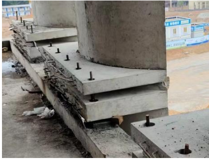
图 6.5.39 节点部位安装就位图
