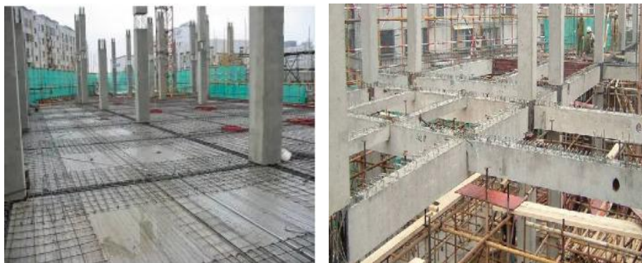
图 2.2.4 装配整体式框架结构体系示意图
