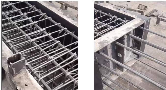
图 3.4.1 预制柱模具制作及钢筋绑扎
