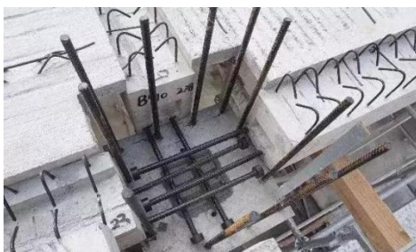
图 2.2.5 框架节点后浇
