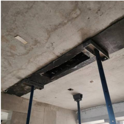
图 4.3.16 加垫防水卷材做法
