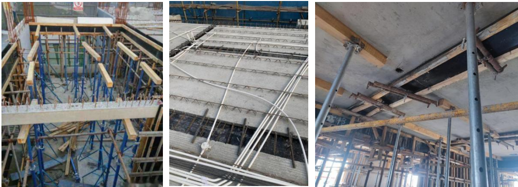
图 4.3.6 叠合板独立支撑与后浇带吊模实景图
