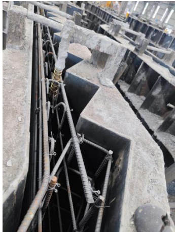
图 3.1.2 脱模吊点预埋件安装
