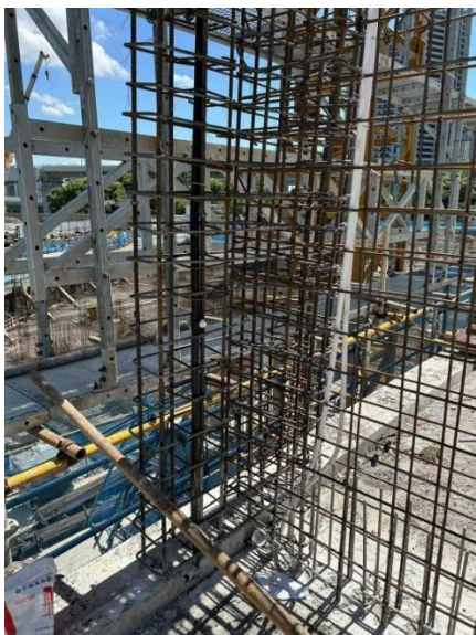
图 6.2.7 T 型节点绑扎效果
