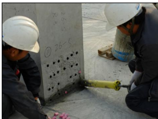
图 4.5.6 预制柱套筒灌浆
