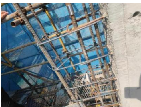
图 4.4.8 一字型节点绑扎效果
