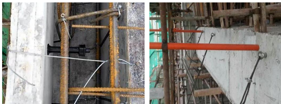
图 5.1.2 预埋连墙件螺栓（现浇结构）
