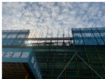
图 6.6.22 预制独立梁安装完成
