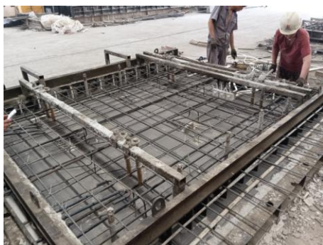
图 3.3.3 内叶板钢筋绑扎
