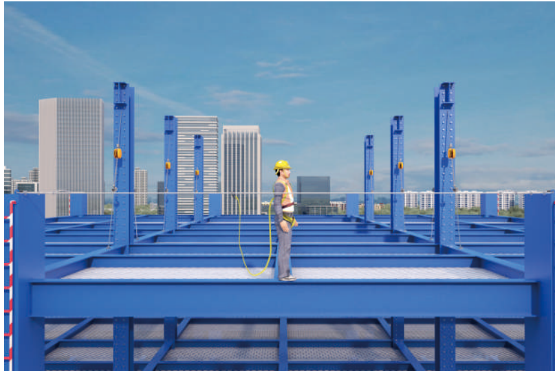
图3.3.4 利用吊耳板拉设水平生命线设置效果图
