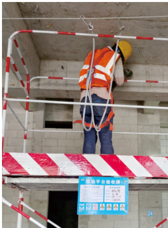
图3.1.2 安全带系挂水平生命线上效果图
