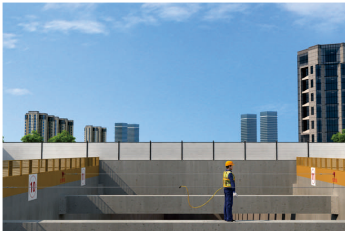
图3.4.4 利用挡水墙设置水平生命线效果图
