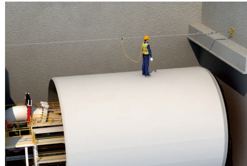
图3.13.1 利用挡水墙拉设水平生命线效果图
