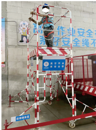
图3.1.1 安全带直接系挂在平台上效果图
