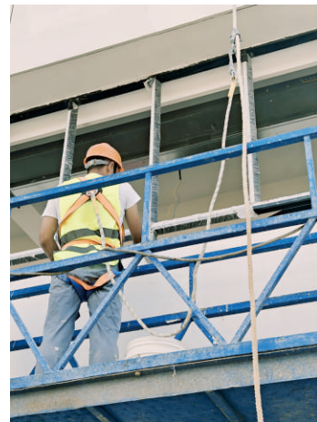
图3.1.13 高处作业吊篮作业人员安全带系挂效果图2
