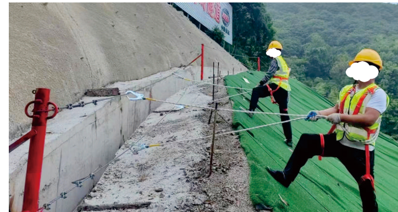
图3.11.1 边仰坡作业人员安全带系挂效果图
