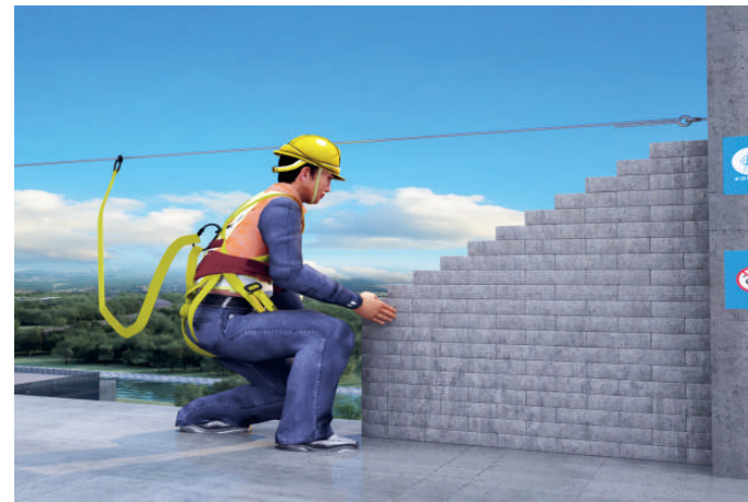
图3.6.1 利用挂点拉设水平生命线效果图
