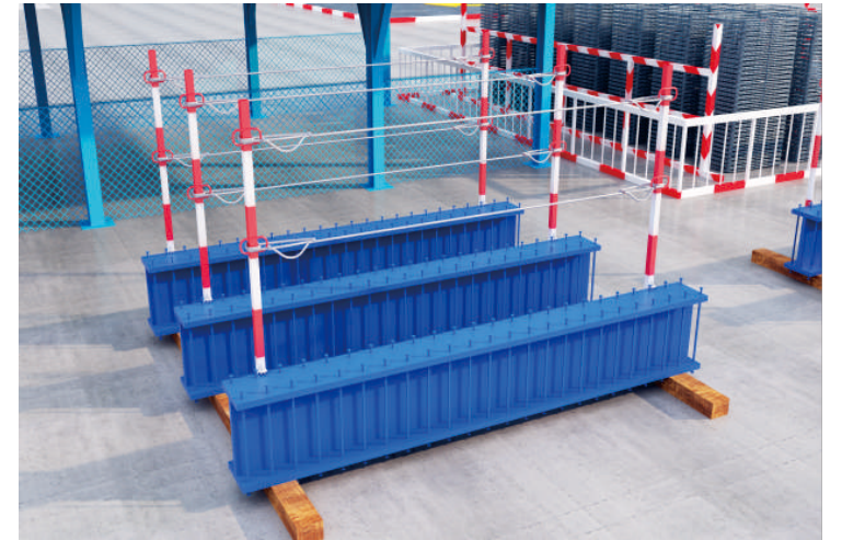
图3.3.1 钢横梁悬空作业水平生命线设置效果图
