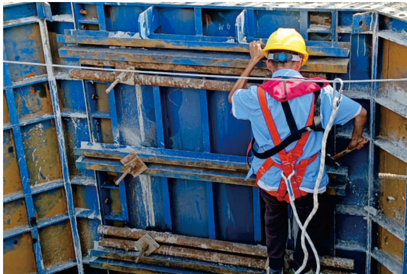
图3.3.8 墩柱模板作业安全带系挂效果图
