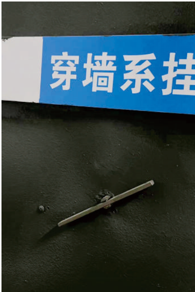
图3.6.9 工具式穿墙螺杆背侧卡扣细节图
