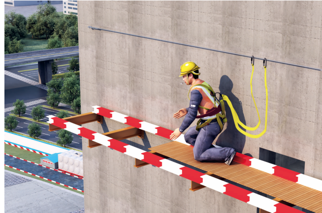
图3.7.1 主体外部拉设水平生命线效果图
