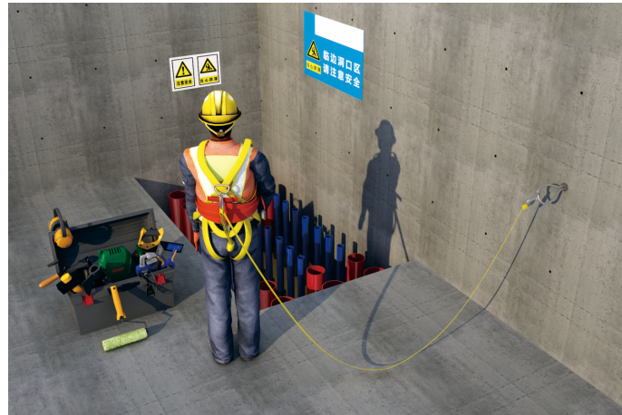
图3.8.3 安全带系挂效果图
