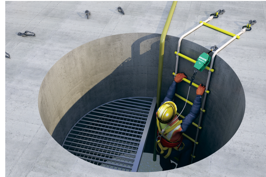
图3.2.1 深井攀爬作业安全带系挂图
