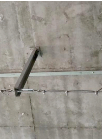
图3.1.3 水平生命线端部固定细节图
