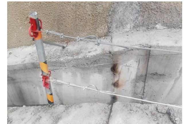
图3.11.2 水平生命线端部固定细节图
