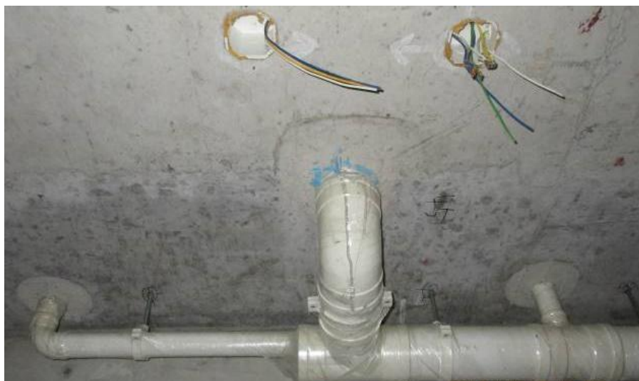
吊洞质量好，分两次封堵
