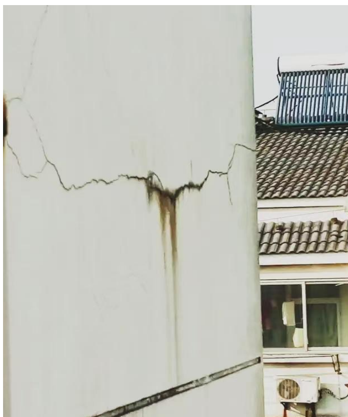
砖砌体外墙（涂料面层）裂缝渗漏水照片
