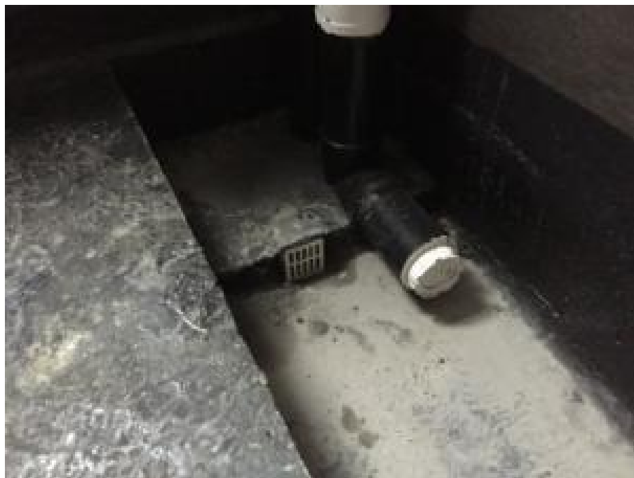
侧排管设置在墙根坑底最低处
