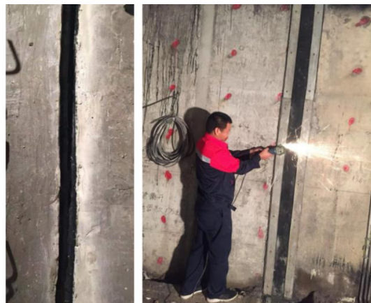
堵漏后增强处理——内贴式止水带
