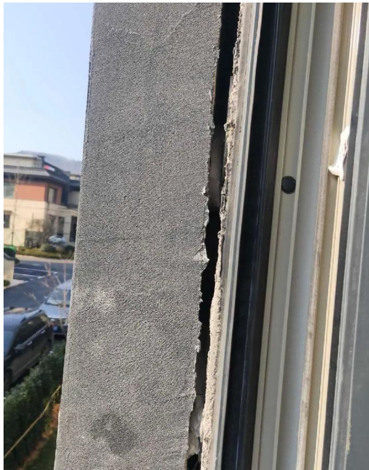
外框窗框与安装基面空隙过大，未采要求进行嵌填密实
