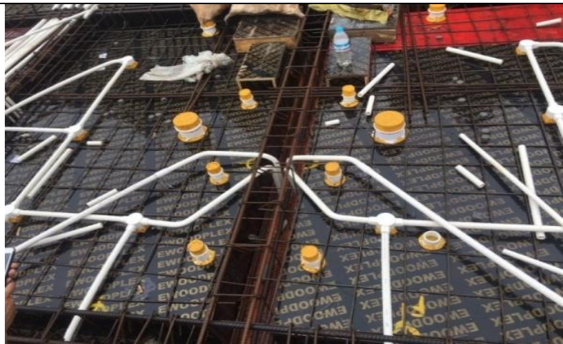
防漏预埋座现场安装照片
