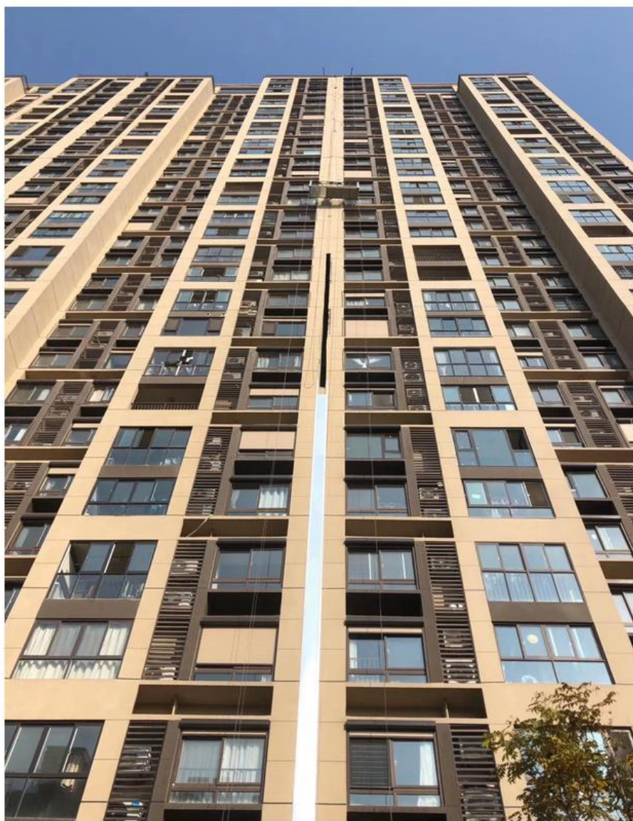
外墙沉降缝、变形缝实景
