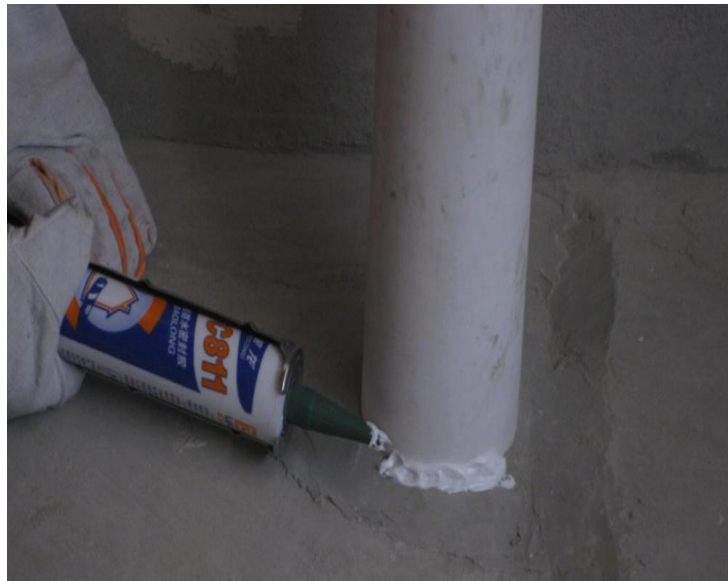
立管管根四周留凹槽并嵌填密封材料
