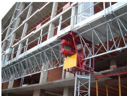
图 3.3.1 电动桥式脚手架
