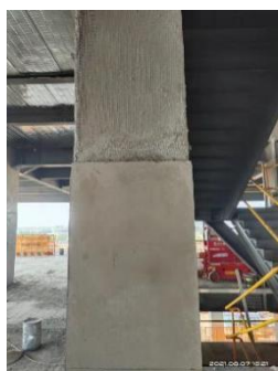
图 5.7.1 面层施工
