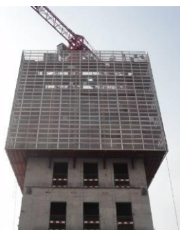
图 3.4.1 液压爬升模板外立面图
