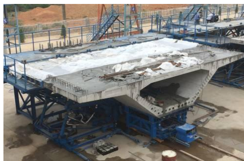
图 3.9.2 短线预制节段箱梁模板
