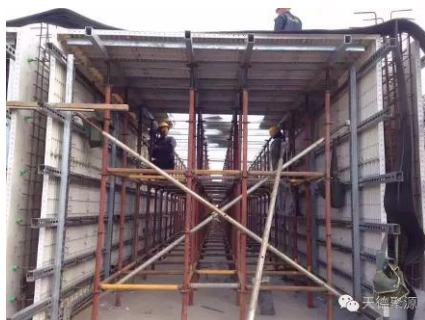
（1）混凝土分两次浇筑的模板
