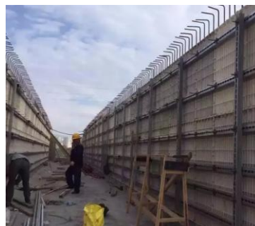
（2）混凝土分三次浇筑的模板
