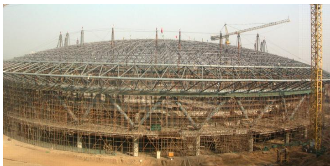
图 5.8.4 钢网架整体顶升技术应用
