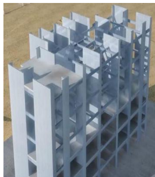
图 5.11.5 钢管束组合剪力墙体系
