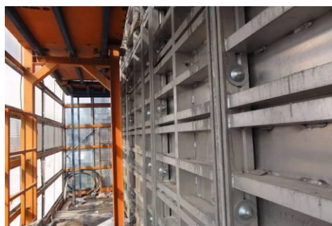
图 3.4.2 爬模模板及架体
