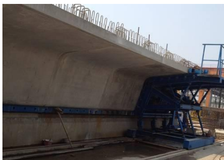
图 3.9.1 长线预制节段箱梁模板
