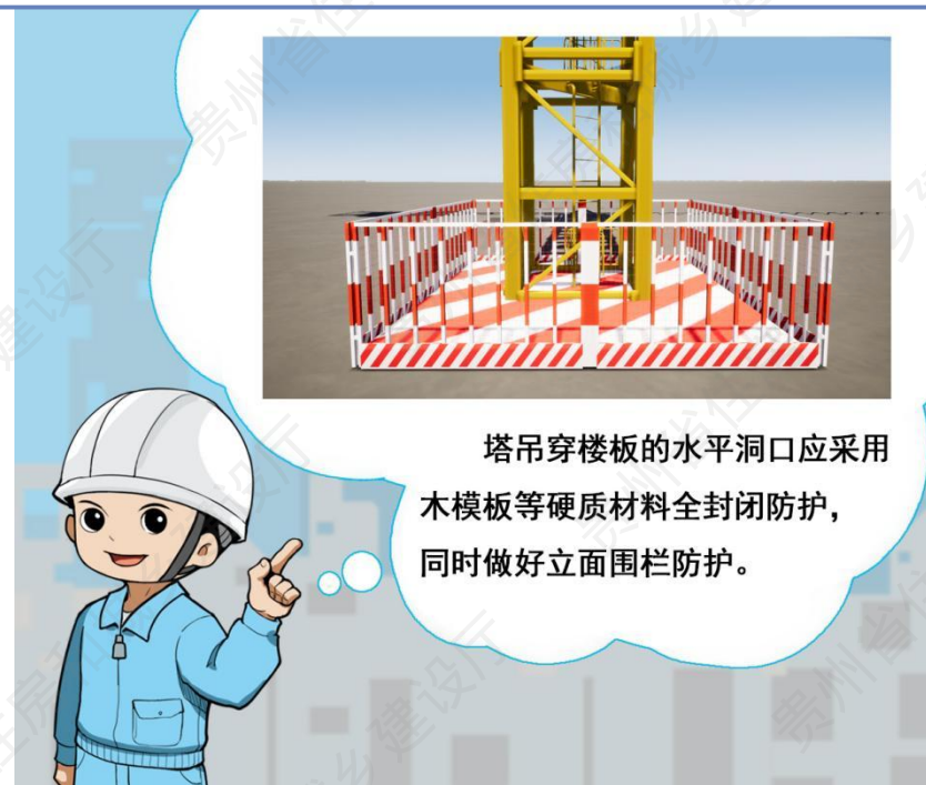
塔式起重机穿楼板洞口防护
