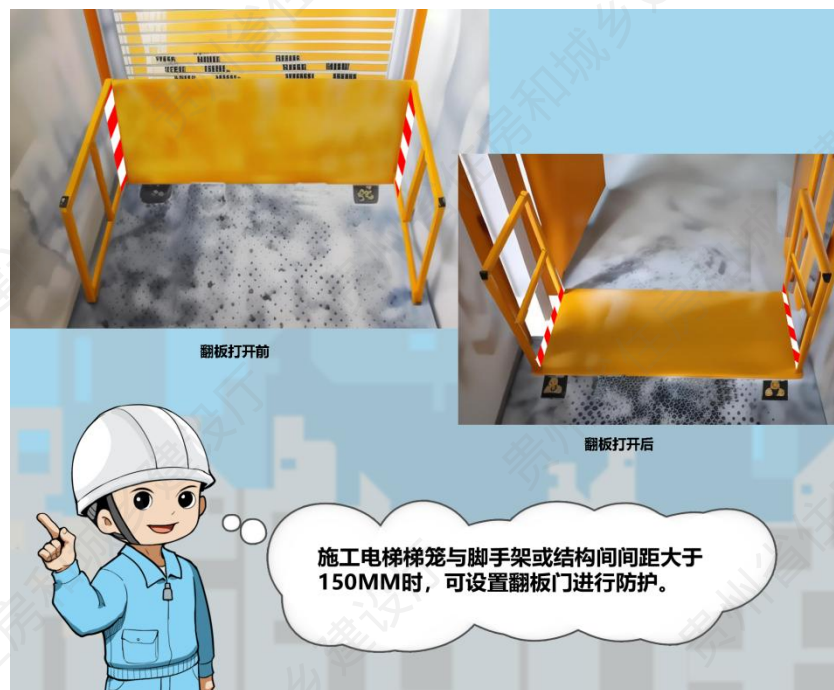
施工电梯梯笼与结构间隙防护
