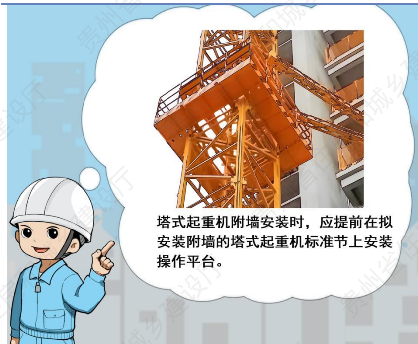
塔式起重机附墙操作平台
