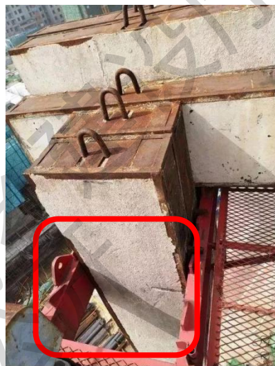
隐患：平衡重洞口缺少防护措施
