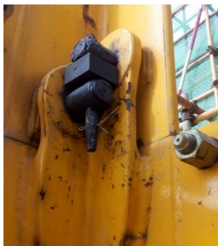
正确示例：连接件规范安装
