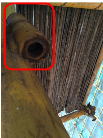
标准节隐患：连接螺栓缺失
