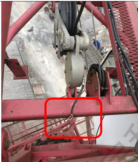
隐患：起重量限制器未接电线
