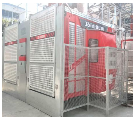
正确示例：防护围栏规范安装
