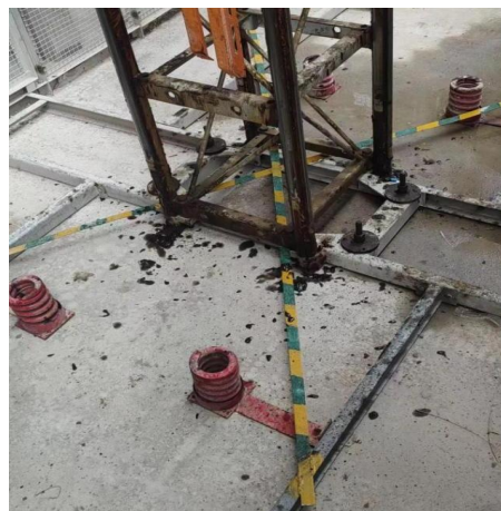
正确示例：规范设置防雷接地
