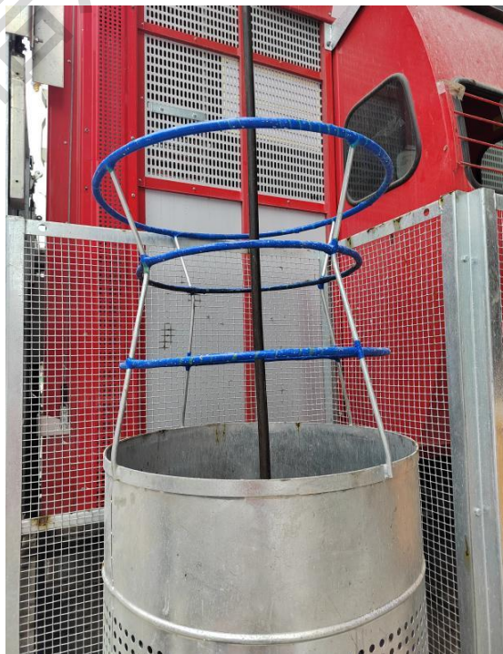
正确示例：规范安装电缆筒
