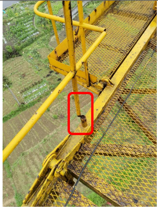
平衡臂部位隐患：护栏立杆断裂
