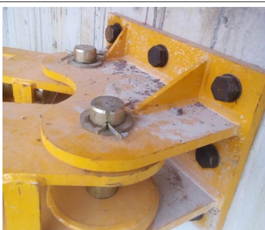
正确示例：销轴销孔紧密配合，开口销规范安装
