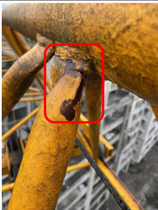
起重臂部位隐患：起重臂腹杆断裂
