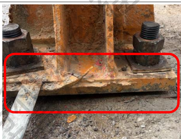
基础部位隐患：基础螺丝松动
