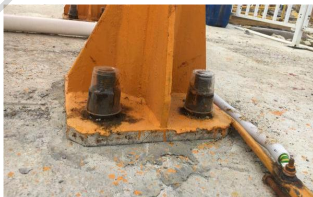
正确示例：基础螺栓规范安装
