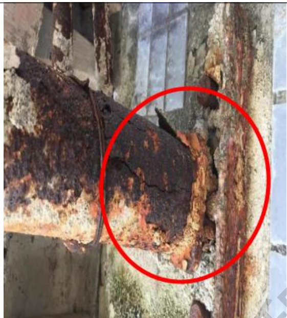
隐患：附墙架严重锈蚀，腹杆开裂
