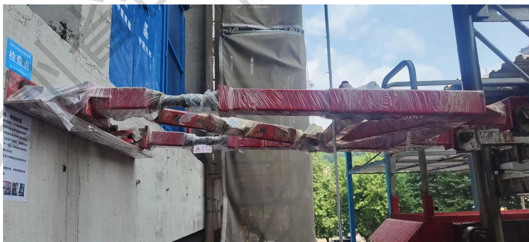
正确示例：使用原厂附墙架
