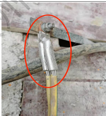
隐患：使用铝芯线做接地线
