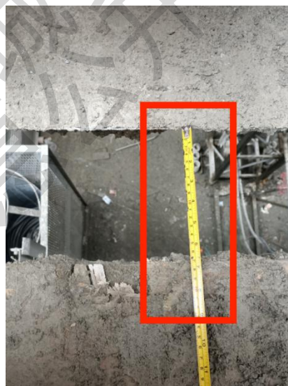
隐患：吊笼门底板边缘与层站平台边缘之间的距离大于 50mm
