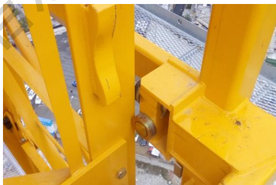
正确示例：爬升架与下支座规范连接，导向轮规范安装
