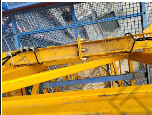
正确示例：附着装置结构件完好、安装规范
