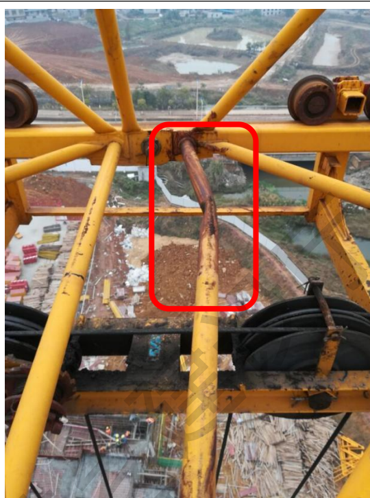
起重臂部位隐患：起重臂水平腹杆变形
