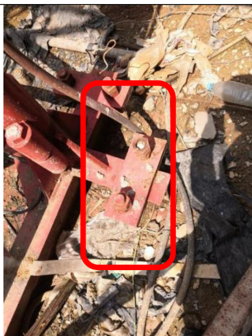
基础部位隐患：基础螺栓漏丝不足
