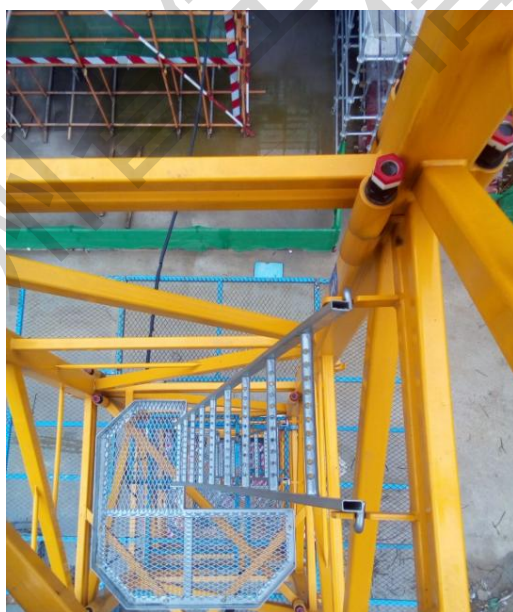
正确示例：标准节规范安装
