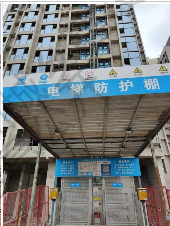
正确示例：按规范搭设防护棚
