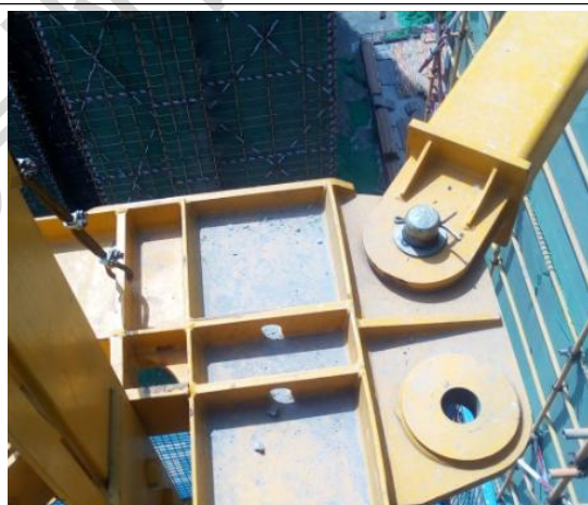
正确示例：销轴销孔紧密配合，开口销规范安装
