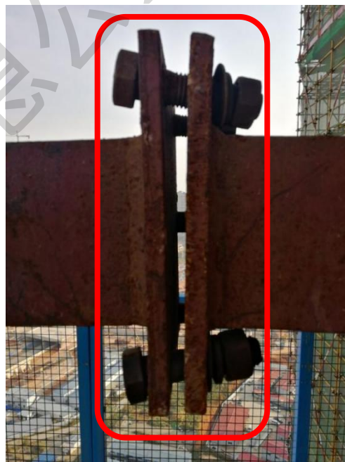
隐患：附着框连接螺栓松动
