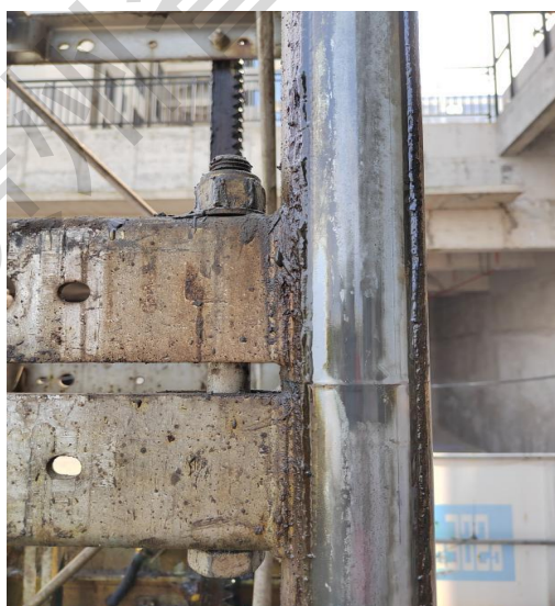
正确示例：标准节螺栓规范安装
