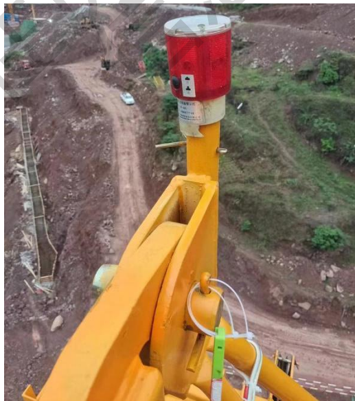
正确示例：障碍指示灯规范安装
