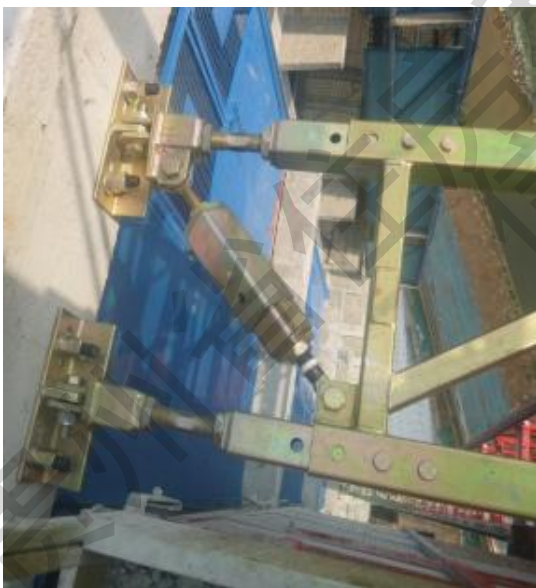
正确示例：附墙连接螺栓规范安装
