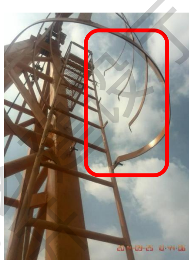
上塔帽通道隐患：护圈损坏
