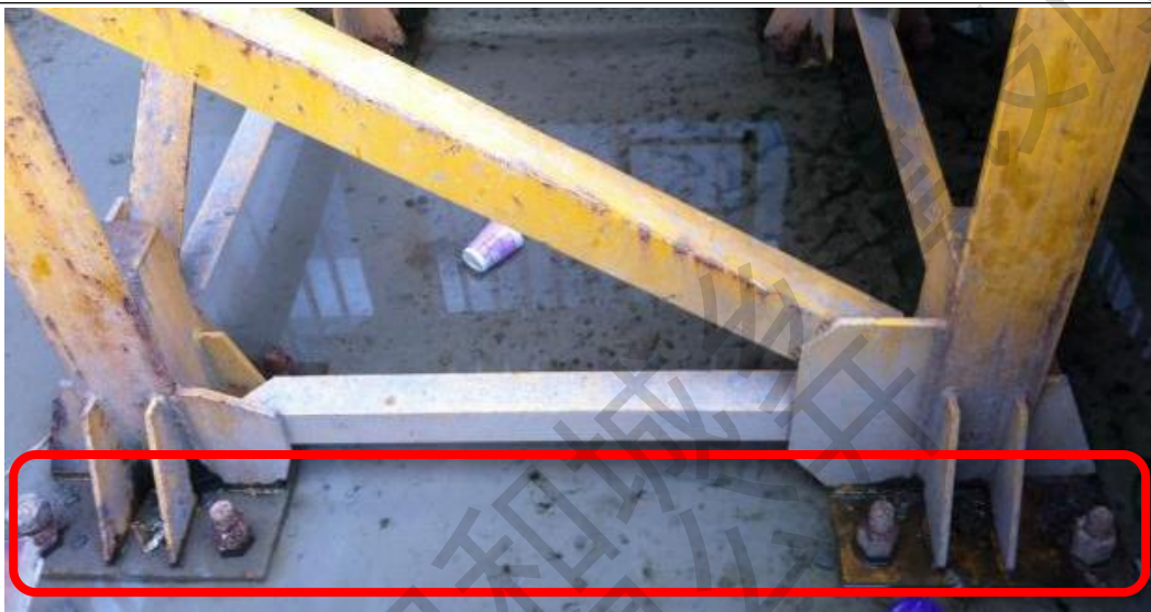
隐患：基础预埋螺栓锈蚀严重
