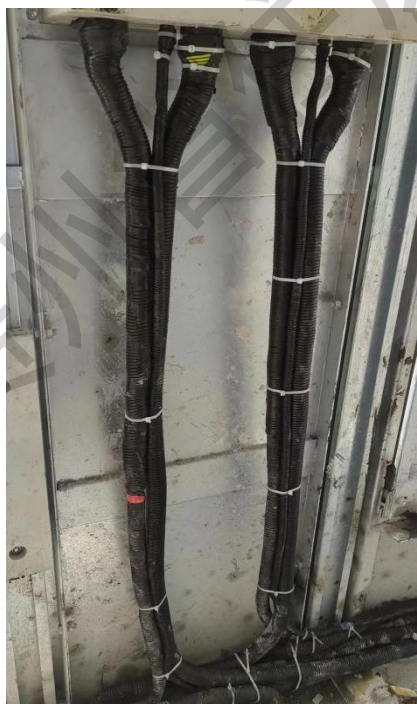
正确示例：电缆线完好，做好绝缘防护
