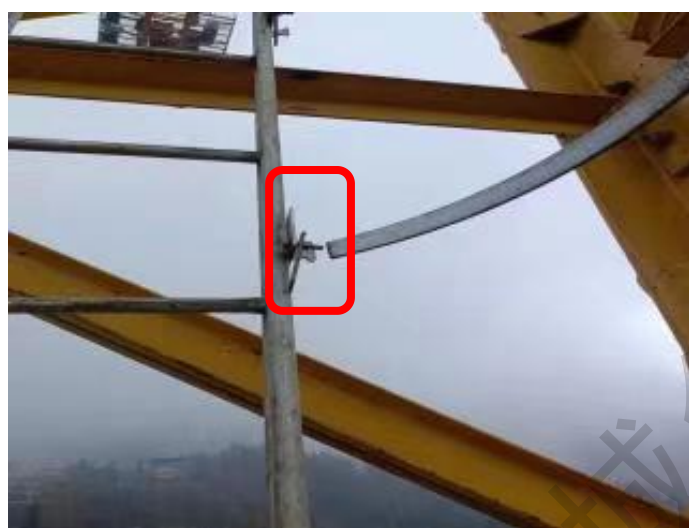
上塔通道隐患：护圈损坏
