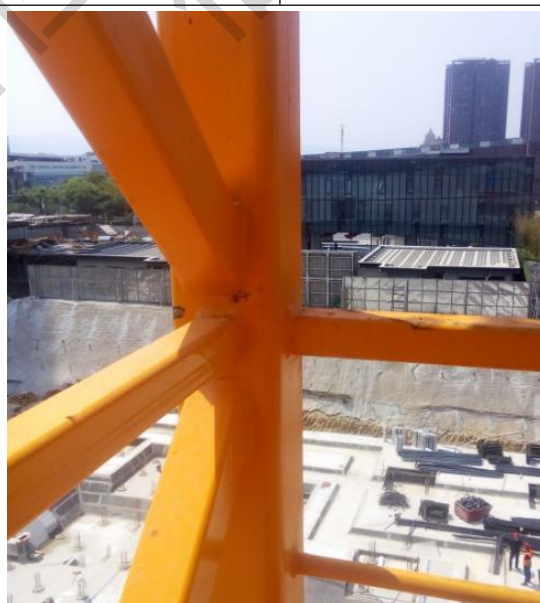
正确示例：结构件完好、无受力缺陷
