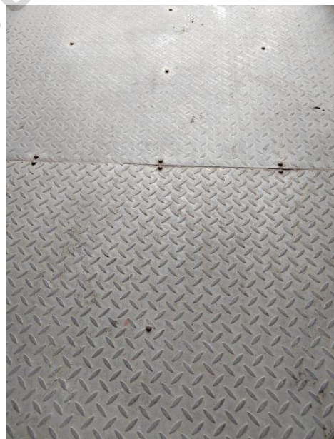
正确示例：吊笼底板完好
