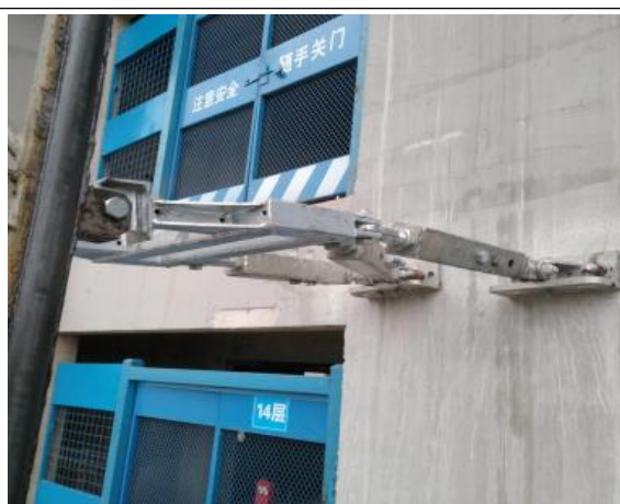
正确示例：附墙架不承受外力
