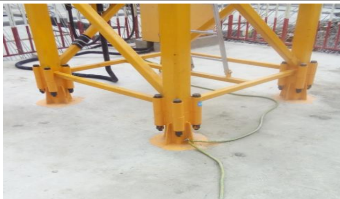
正确示例：基础完好、无缺陷
