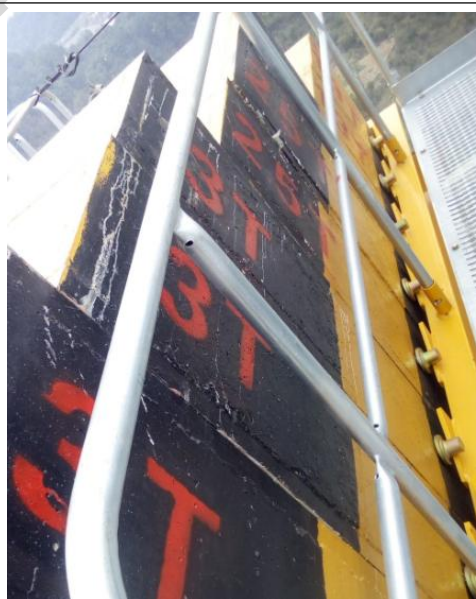
正确示例：配重完好，安装规范
