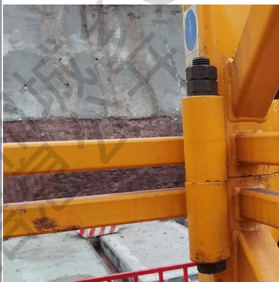
正确示例：标准节螺栓规范安装
