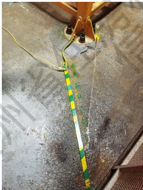
正确示例：防雷接地、重复接地规范设置
