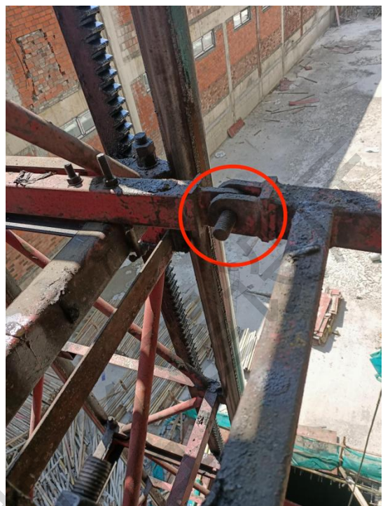
隐患：附墙连接螺栓螺帽缺失
