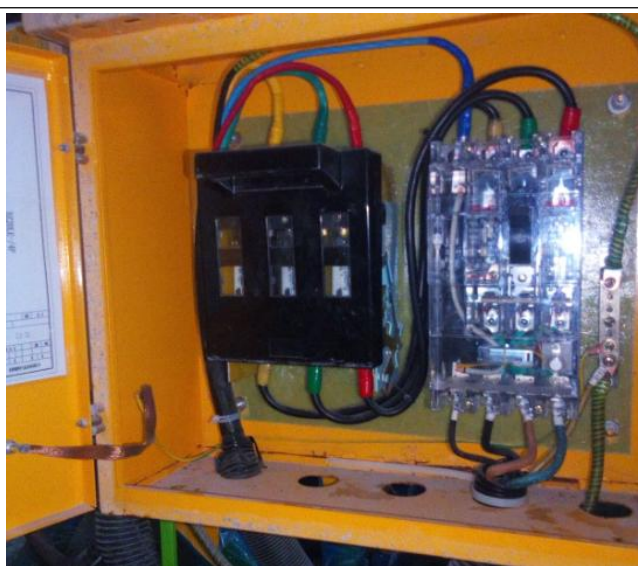
正确示例：开箱电气元件规范配置，接线规范
