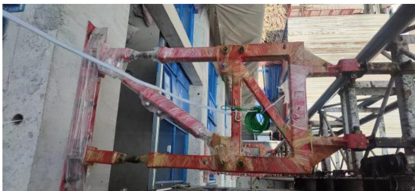
正确示例：附墙架结构完好、无受力缺陷
