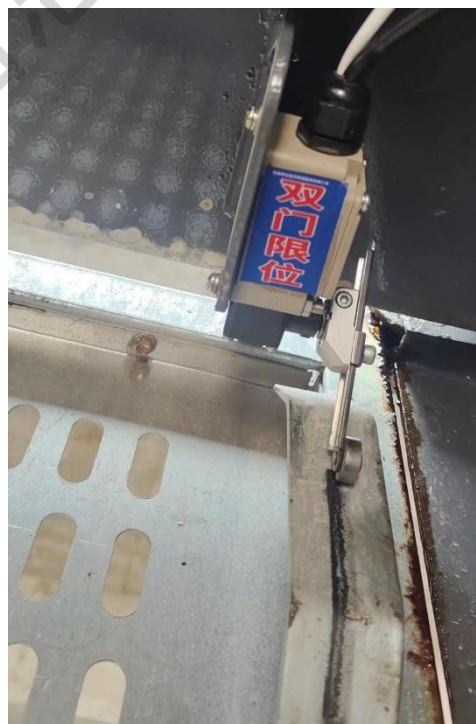
正确示例：机电连锁开关规范安装、动作灵敏
