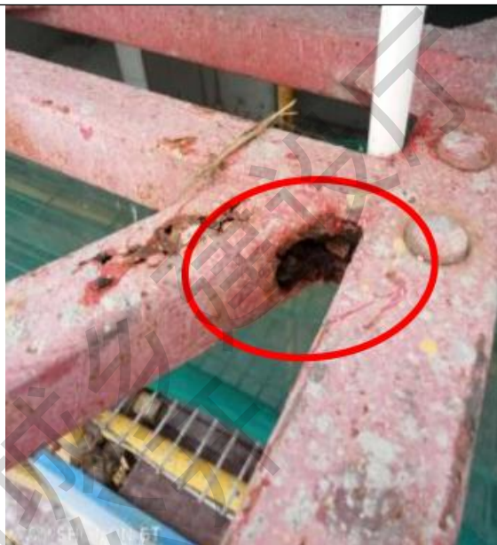
隐患：附墙架严重锈蚀
