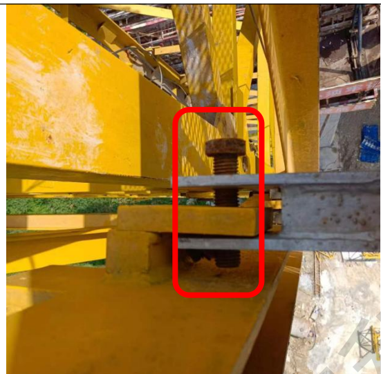
隐患：套架平台固定螺栓螺帽缺失
