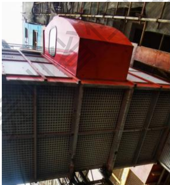
正确示例：吊笼底板完好
