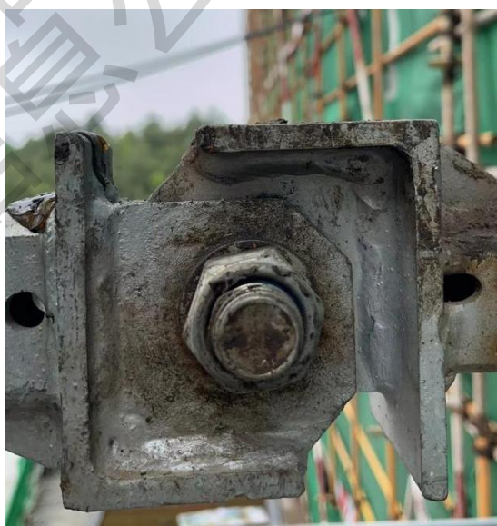
正确示例：附墙连接螺栓规范安装
