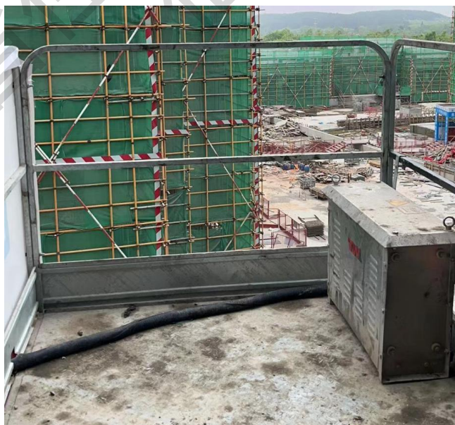
正确示例：笼顶防护齐全
