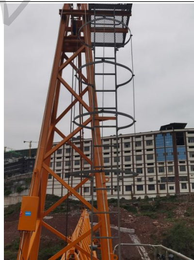
正确示例：护圈完好
