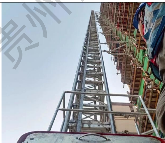
正确示例：附墙间距及悬高符合要求
