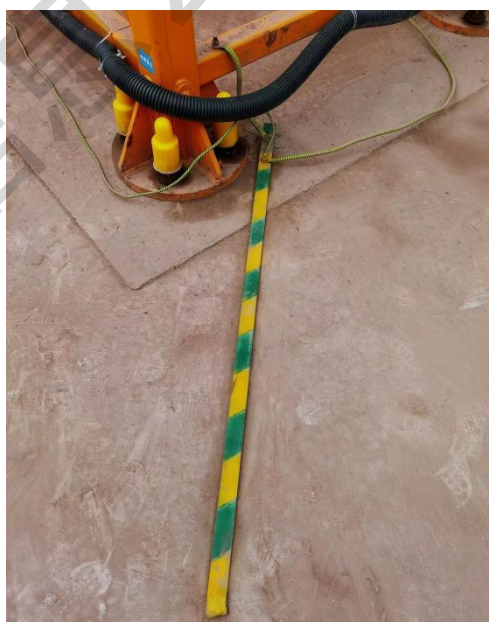
正确示例：防雷接地、重复接地规范设置
