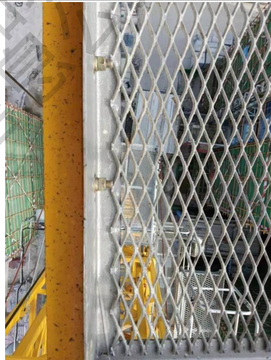
正确示例：螺栓紧固到位
