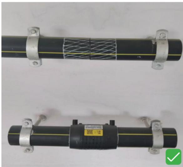
1. 管材插入电熔管件承口内，并标记位置。
