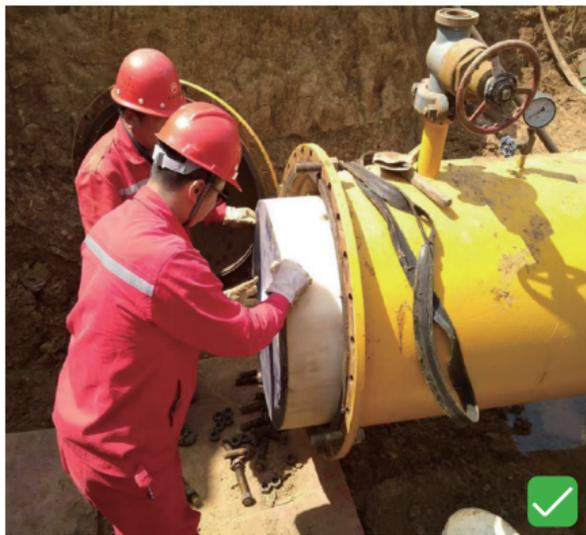
1. 聚乙燃管道和公称尺寸小于DN100或长度小于100m的钢质管道，采用气体吹扫。
