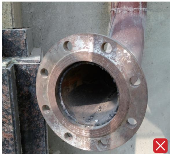
1. 法兰与管道规格不匹配，未插入法兰内即焊接。
