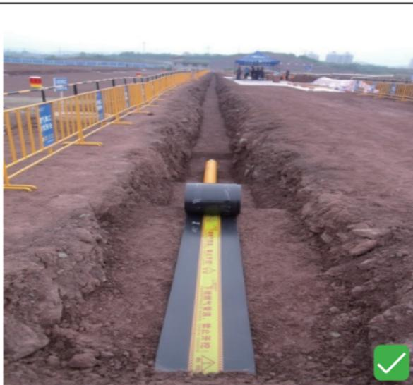
1. 警示板平整敷设在管道正上方，警示语正面向上。
