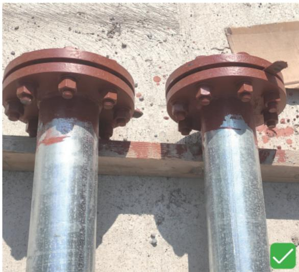
1. 法兰连接平行、与管道中心线垂直。
