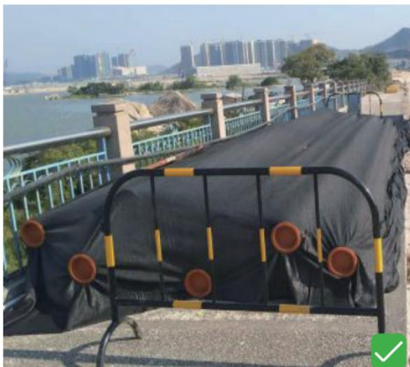
1. PE管材露天堆放采用遮盖物防雨防晒。
