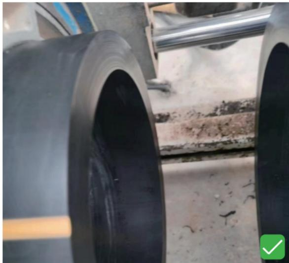
采用专用工具切割，端面平整、光滑、无毛刺。
