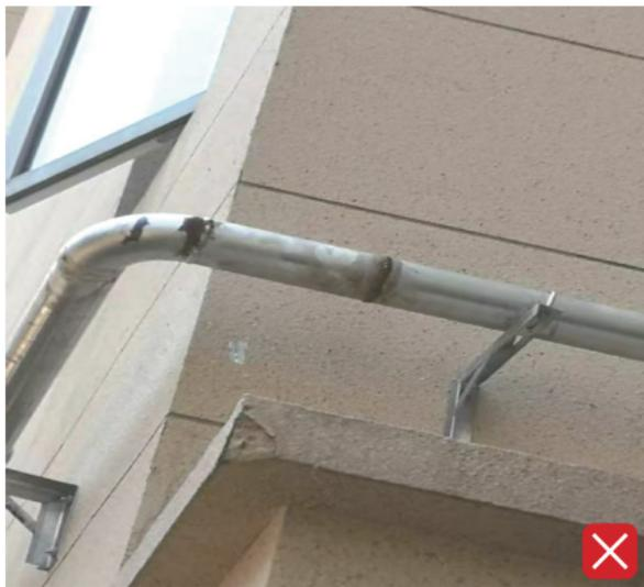
1. 钢管除锈或底漆涂刷不到位，导致漆膜剥落、锈蚀。
