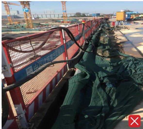
电缆敷设无绝缘挂钩，沿围挡挂设。
