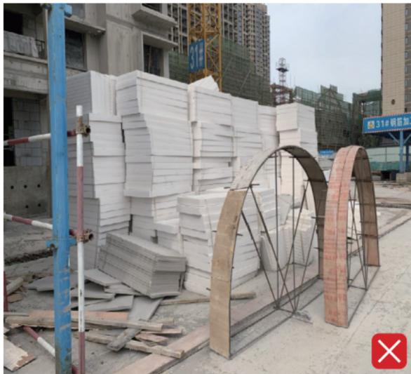
1. 建筑外保温材料堆码在坠落半径内。
