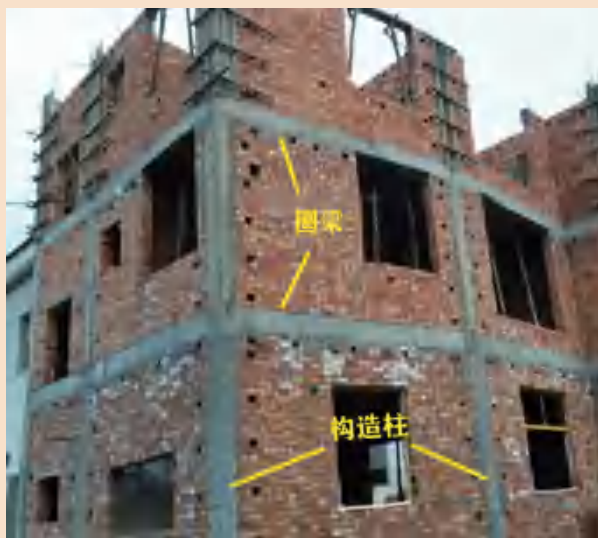
设有圈梁、构造柱
