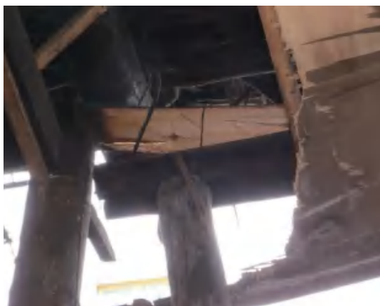
木构架破坏断裂
