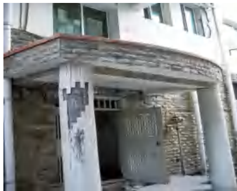
柱保护层脱落
