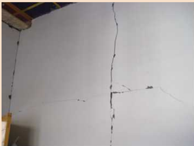
裂缝长度超过墙段高 1/2 的竖向裂缝
