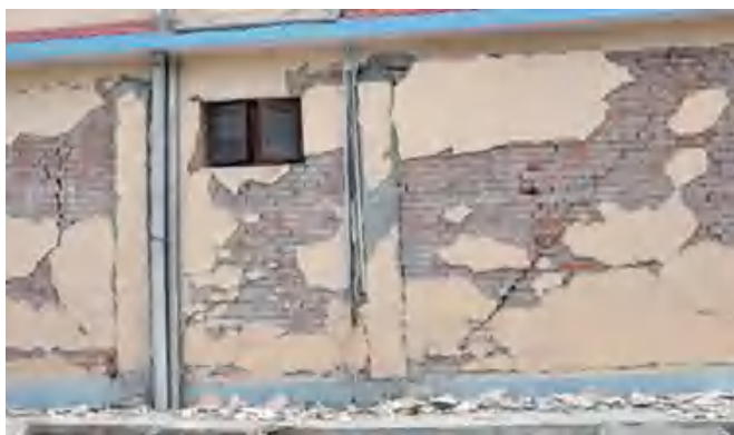
砌体填充墙出现明显斜裂缝
