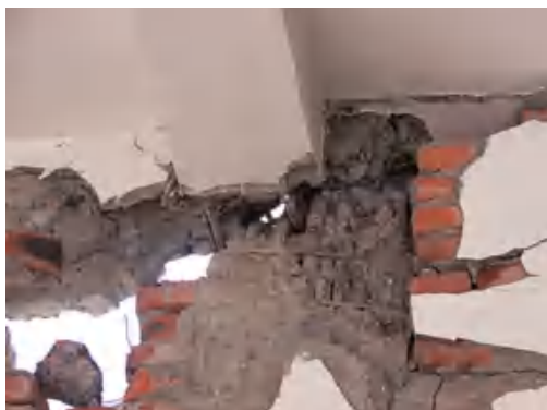
填充墙和框架梁脱开错动
