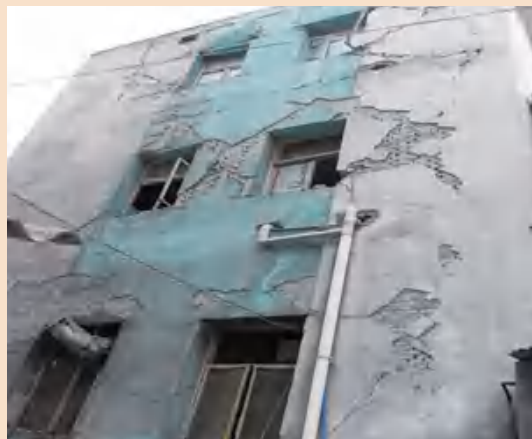
窗上墙体斜裂缝
