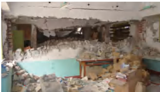
填充墙局部倒塌
