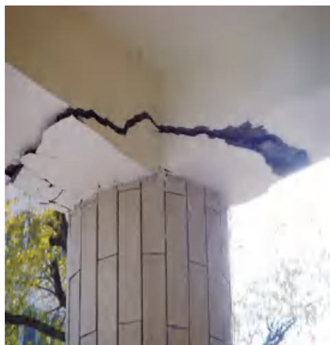
柱端部压裂
