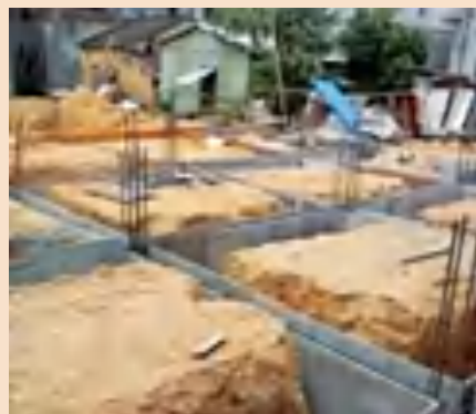
混凝土条形基础
