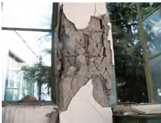
柱出现保护层脱落且具有交叉裂缝
