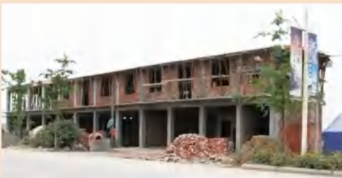
底部框架—上部砌体结构
